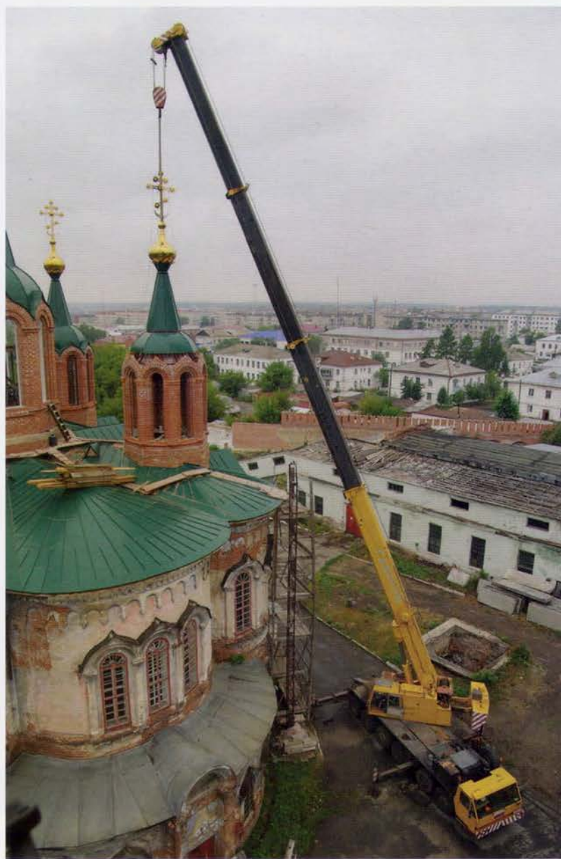
Установка куполов на Скорбящен- ской церкви. 2010 г. Фото А.Н. Хитайленко
